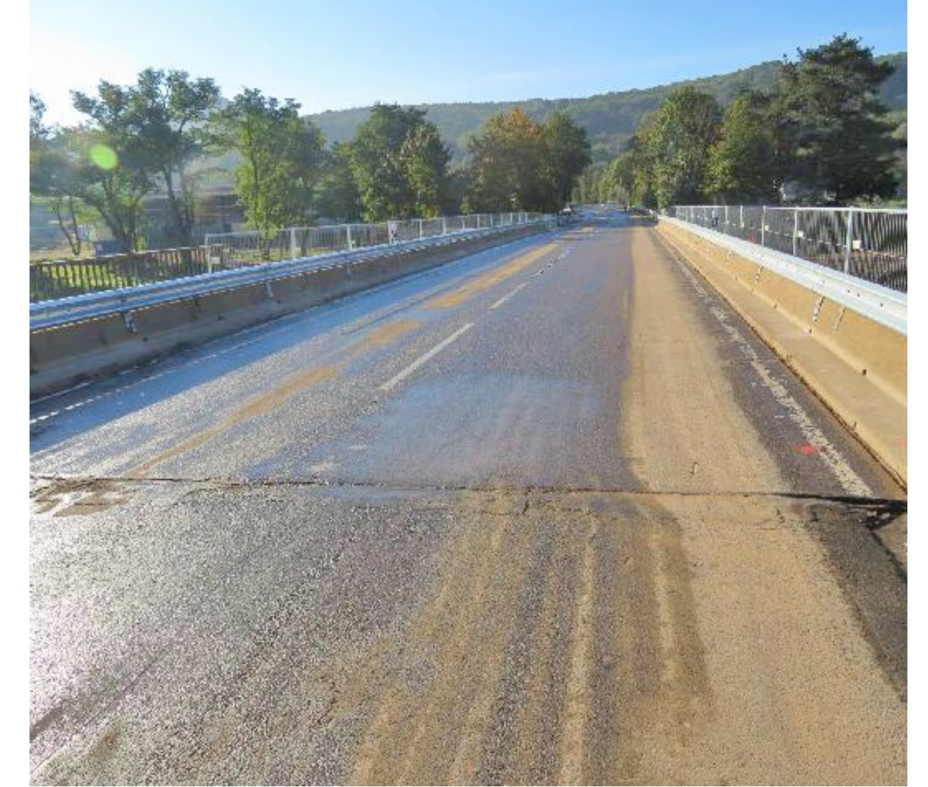
Brückenübergang nach Wiederherstellung des Auflagers (Foto: Becker Ingenieure GmbH)
