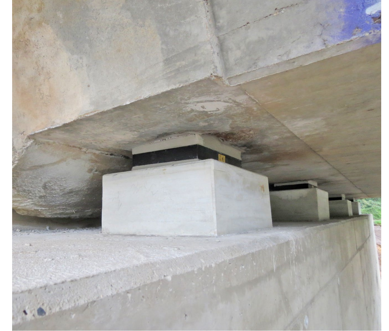
Überbualagerung auf neuem Widerlager (Foto: Becker Ingenieure GmbH)
