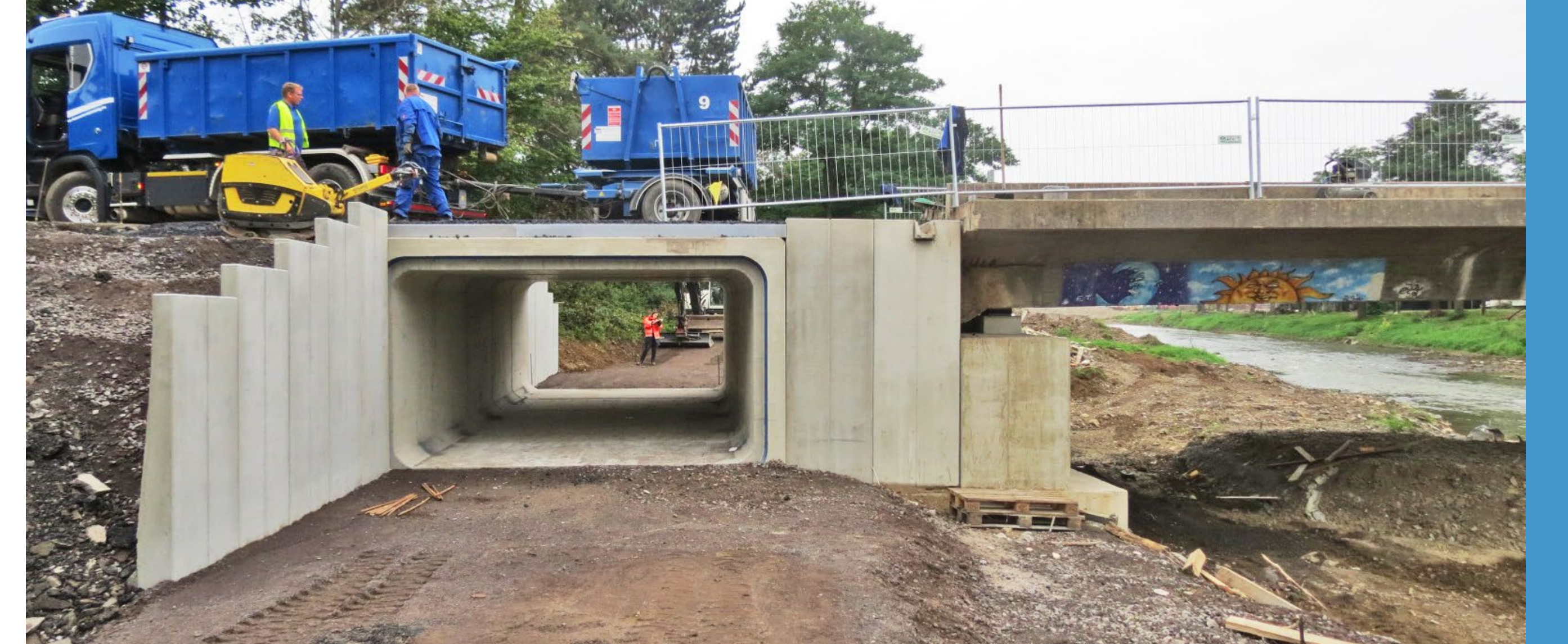
Fußgängerquerung (Foto: Becker Ingenieure GmbH)
