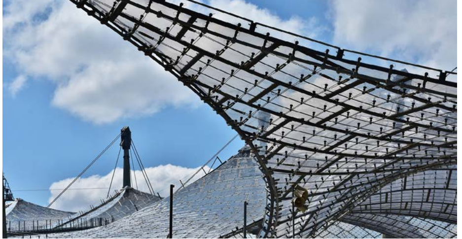
Trägt bald den Titel "Historisches Wahrzeichen der Ingenieurbaukunst in Deutschland": Das Dach des Münchner Olympiastadions.
