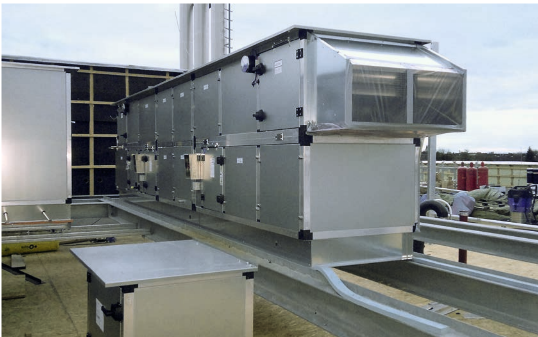
Ansicht einer Dachlüftungszentrale, Schulzentrum an der Gerastraße, München
