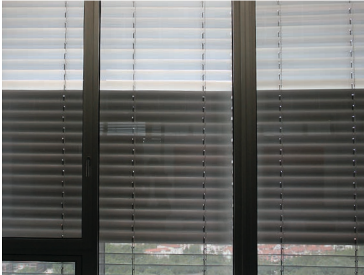
Sonnenschutz mit Tageslichtlenkung oben und Sichtbeziehung nach außen durch Lochung unten
