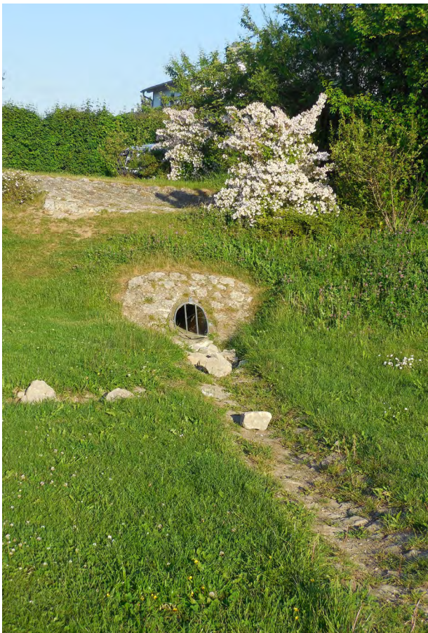
Abb. 46 Zulauf des Regenwassers
