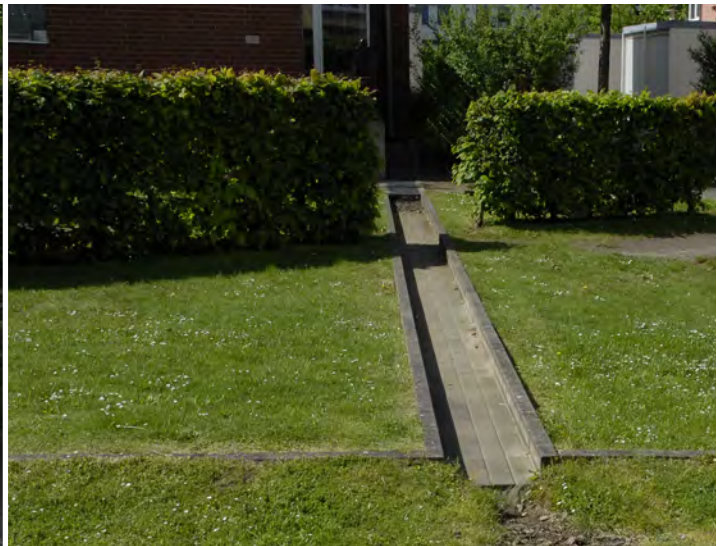
❖ Abb. 27 Sammelrinne zur Ableitung auf Rasenfläche
