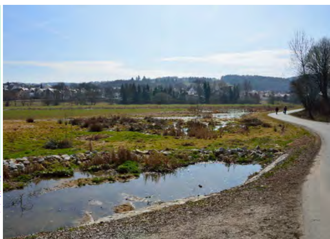
Abb. 54 Umleitung des gesammelten Niederschlagswassers
