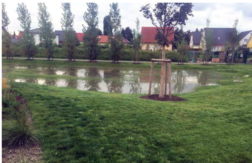
Abb. 43 Zentrale Regenrückhaltefläche in einem Wohngebiet
