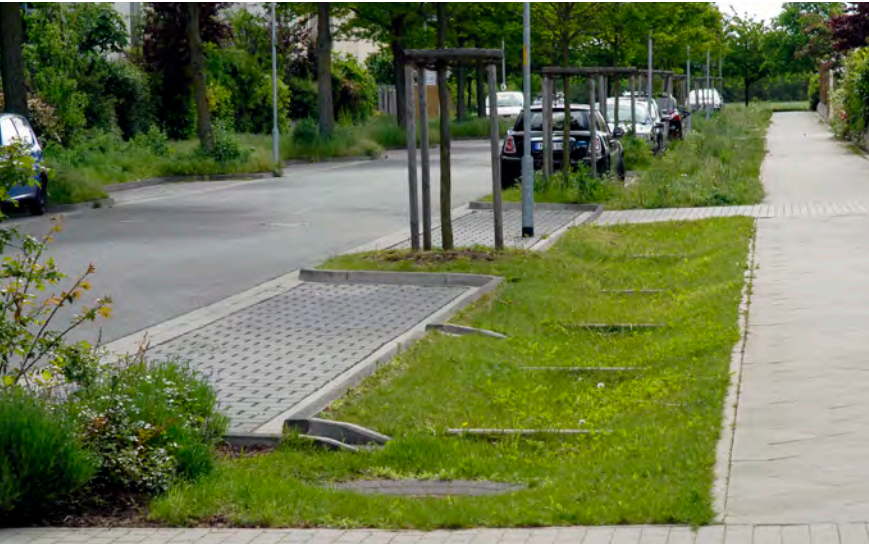
Abb. 22 Muldenkaskaden zur Versickerung von Straßenabflüssen
