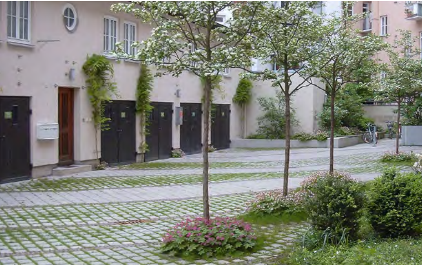
Abb. 15 Durchlässige Beläge in einem Innenhof
