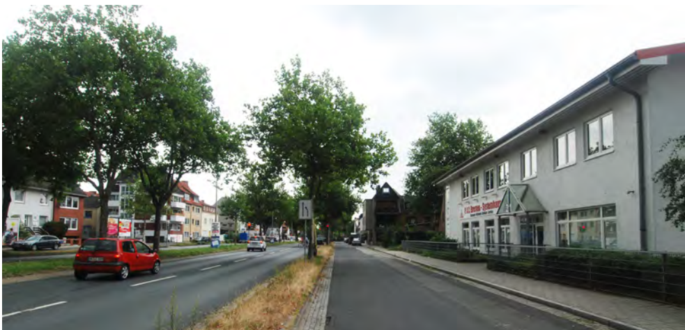
❖ Abb. 28 Ist-Zustand: Die Verkehrsfläche ist stark versiegelt. Im Falle eines Starkregens kann es zu unkontrollierten Abflüssen des Wassers und Überflutungen kommen. Dies kann Schäden an den angrenzenden Gebäuden hervorrufen.
