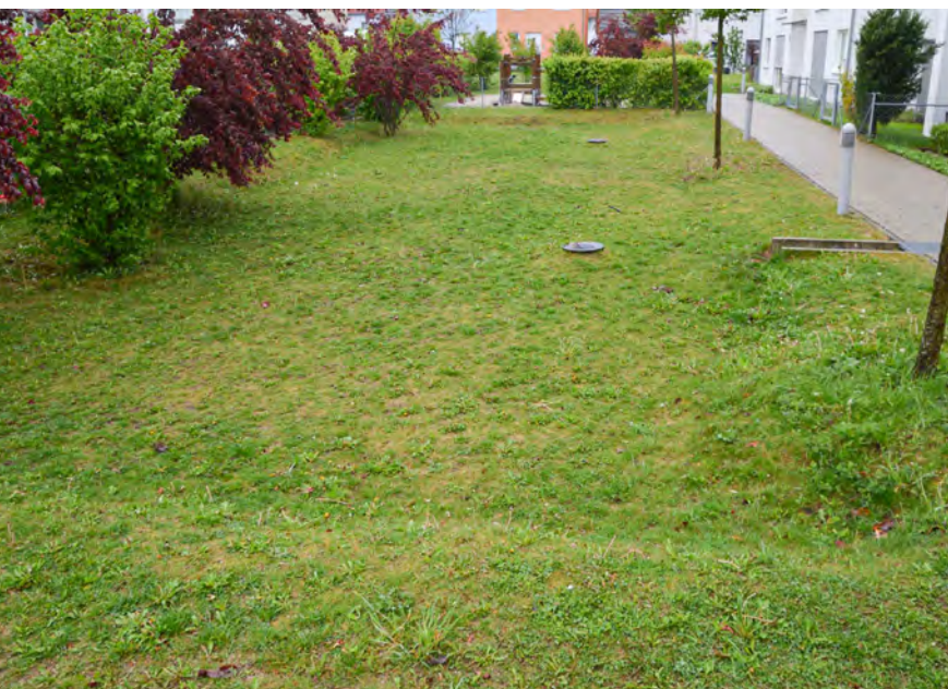
••• Abb. 44 Dezentrale Versickerungsfläche im Wohngebiet
