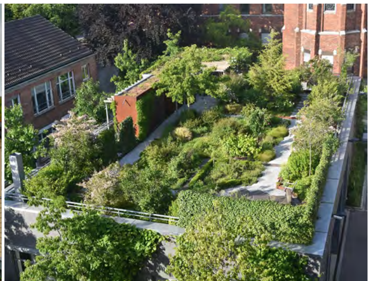
Abb. 19 Intensives Gründach auf einem Verwaltungsgebäude
