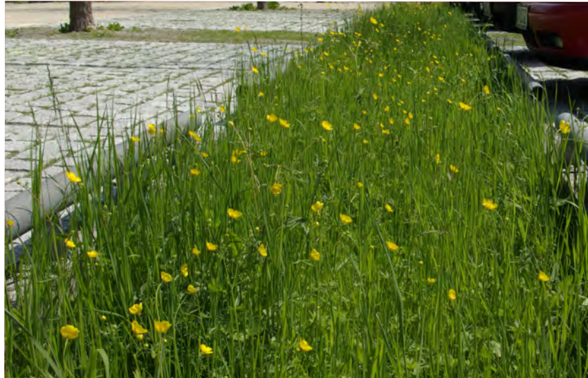
Abb. 24 Rasenpflaster und Muldenversickerung
