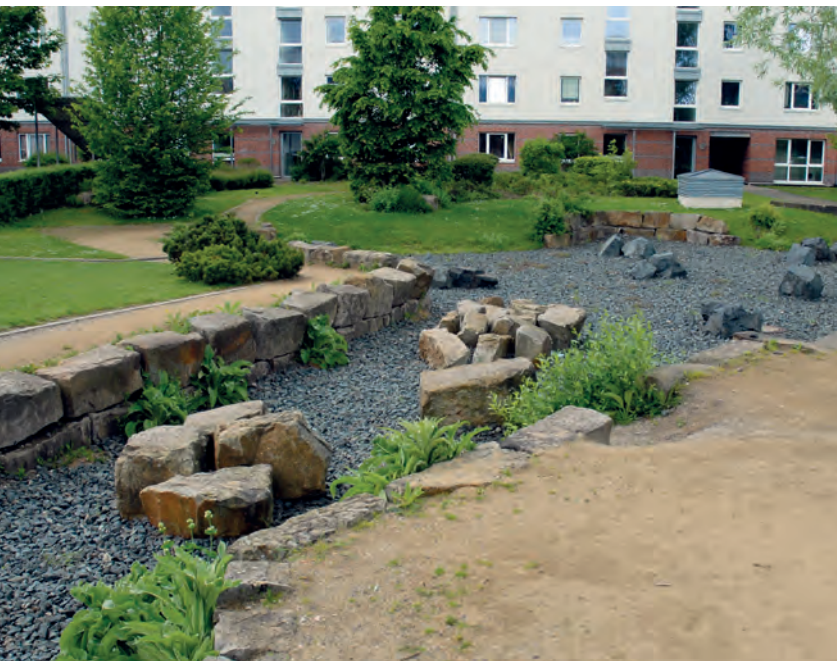
Abb. 11 Regenrückhaltefläche in einem Blockinnenhof
